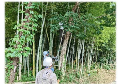
① 車の通行の支障となる枝をハンディチェーンソーで伐採
