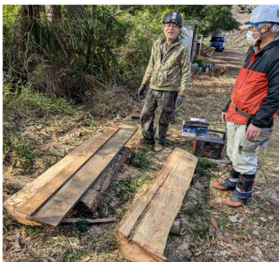
間伐材を使って看板作成のための板作り
